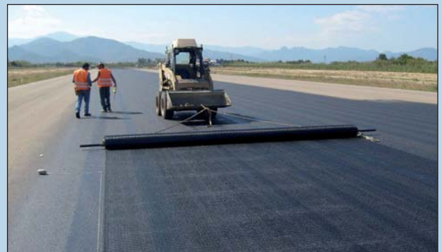
Figura 3 - La stesura della geogriglia PAVIROCK TGB
