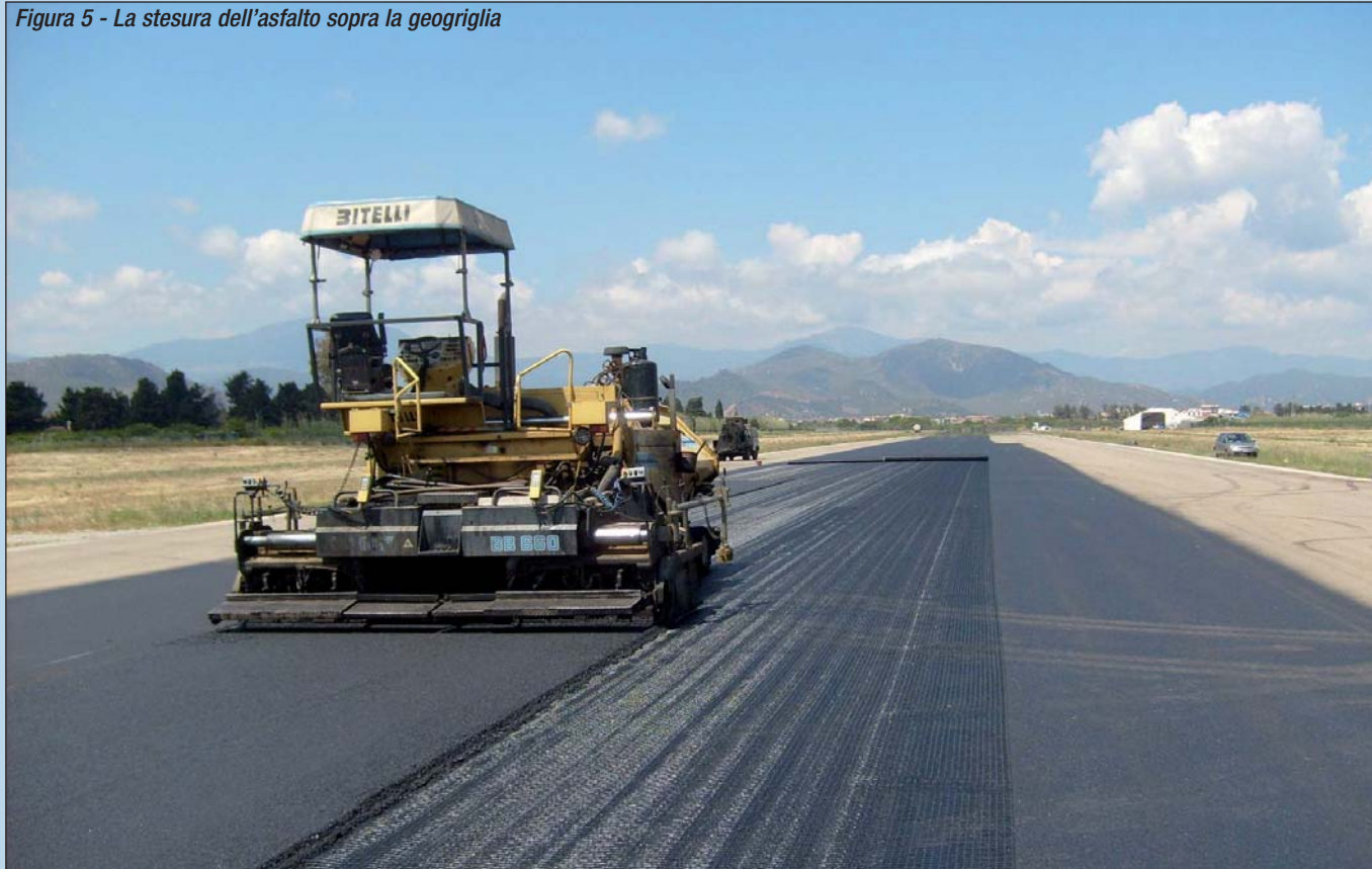
Figura 5 - La stesura dell'asfalto sopra la geogriglia
